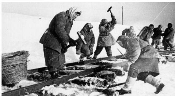
Ремонт узкоколейки. Киров, 1941 г.
