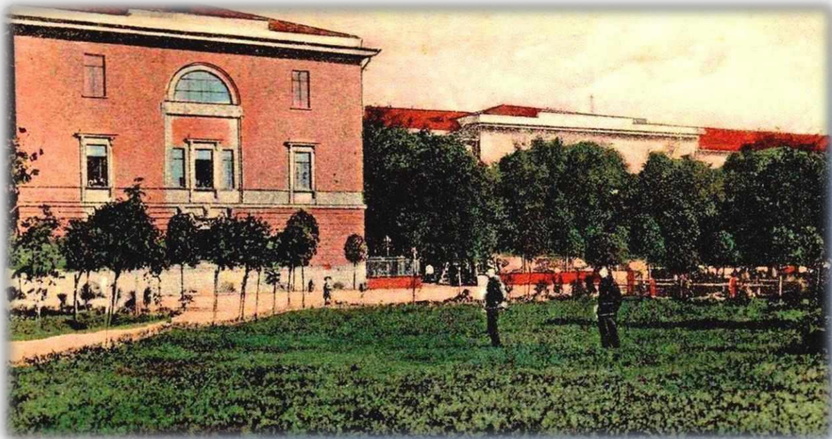
Здание морского госпиталя в Кронштадте, конец XIX в.
